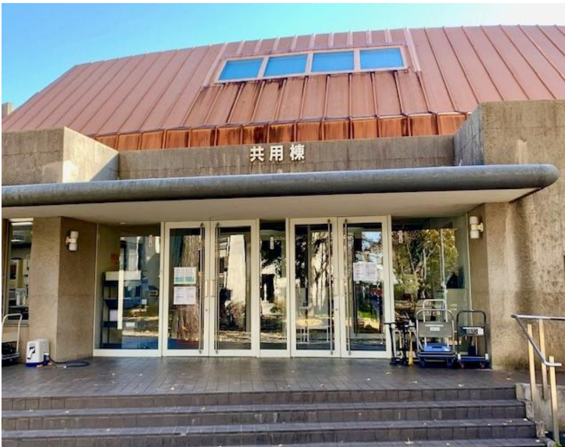
共用棟 事務室・多目的ホール
