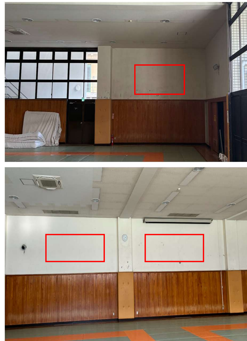
柔道場内部（側面）
