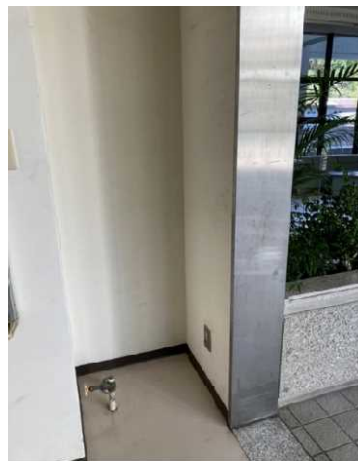
⑤ 15号館1階 設置想定有り 給排水・電源有り
