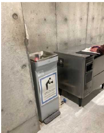
⑦ 第2体育館1階 ウォータークーラー有り 給排水・電源有り 隣接して製氷機有り
