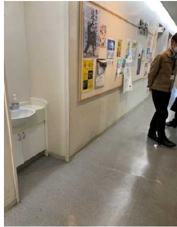
② 5号館1階 給排水あり 電源無し
