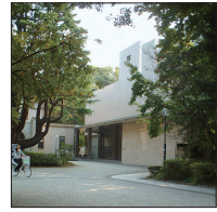
学際交流棟 アドミニストレーション棟
