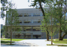
駒場図書館（図書館棟）
